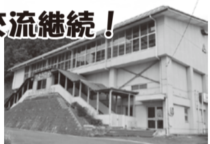
当時避難場所となった旧荒小体育館
